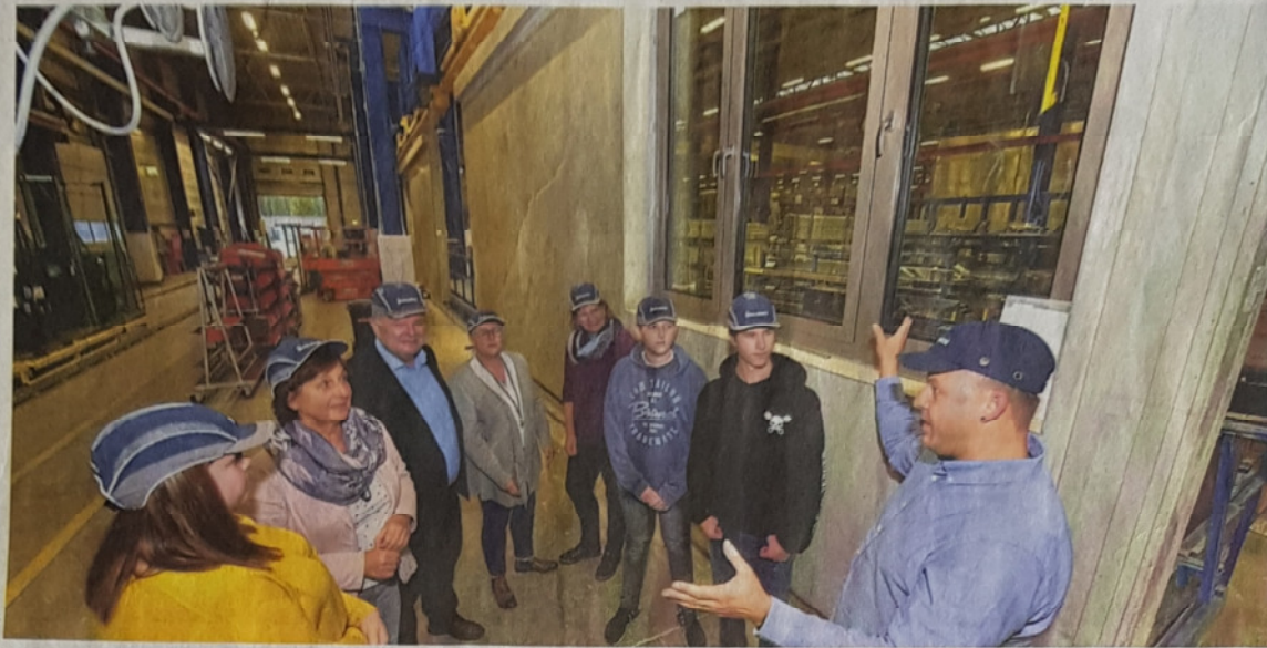
Hauswand-Produktion am Fließband: Goldbeck-Ausbilder Heiko Radau (rechts) und Werkleiter Marcus Gross (Dritter von links) zeigen den Gästen der Erlenbachschule im Uentropfer Betonwerk eine Fertigungslinie für komplette Gebäudewände.
